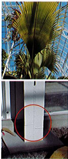
傷んだ鉄骨部分を切断し、新しい材料を溶接して補修。溶接跡が見えるように塗装しています。
